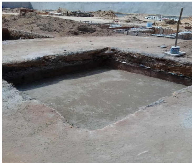
Figura 3 – Sapata na profundidade 1,15m pós compactação das camadas
