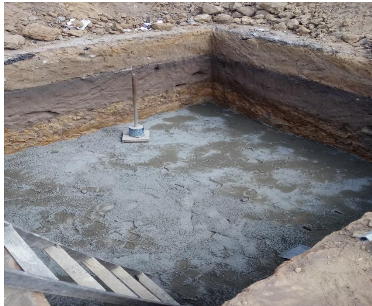
Figura 2 – Sapata na profundidade 1,70m em relação ao N.T. durante a compactação das camadas de solo
