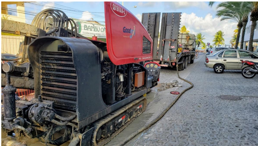
Figura 04: Máquina de perfuratriz rotativa. Fonte: Acervo Pessoal (2019).
