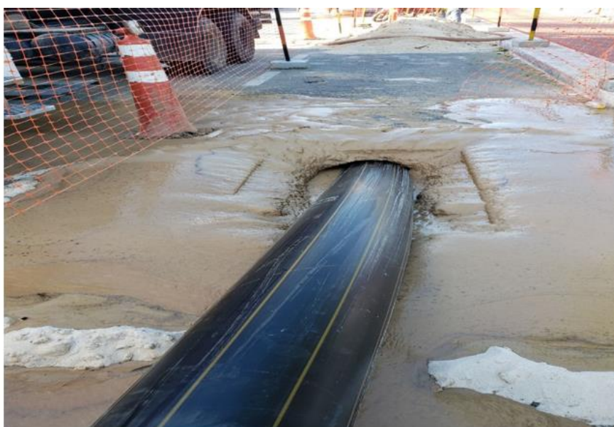
Figura 7: Inserção da tubulação. Fonte: Acervo Pessoal (2019).
