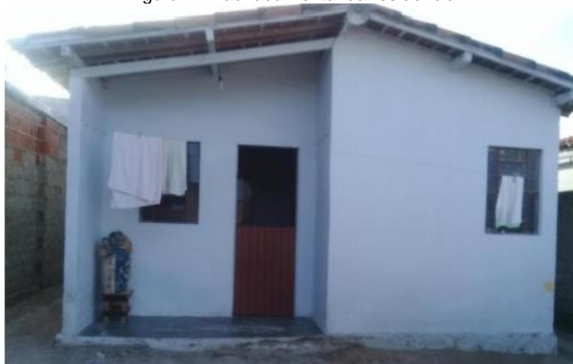
Figura 2 - Fachada frontal da residência.
