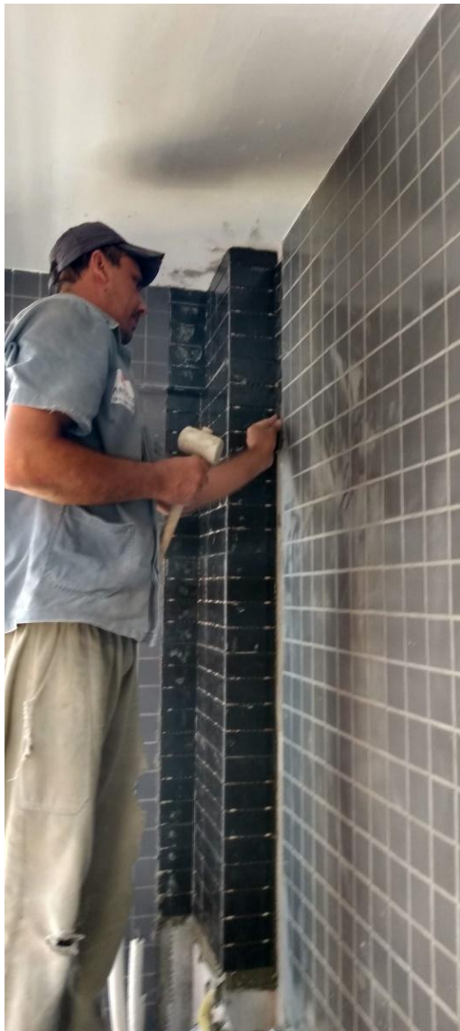
Figura 12 – Pedreiro que foi deslocado da sua frente para finalizar a fachada noroeste na chegada das pastilhas faltantes.
