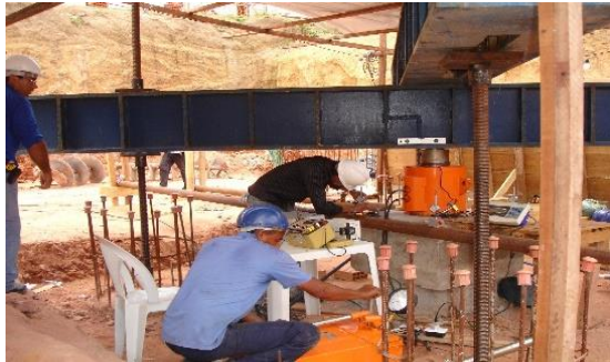
Figura 7 – Instalação dos extensômetros.
