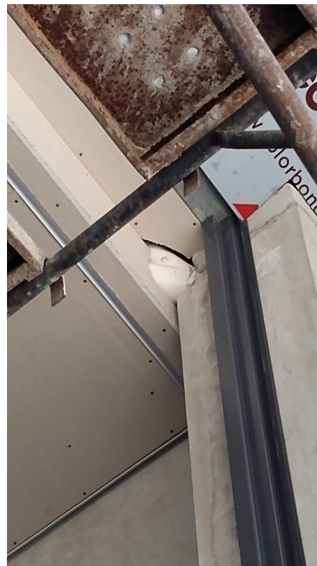
Figura 24 - Forro finalizado do Lobby com a tubulação para fora.
