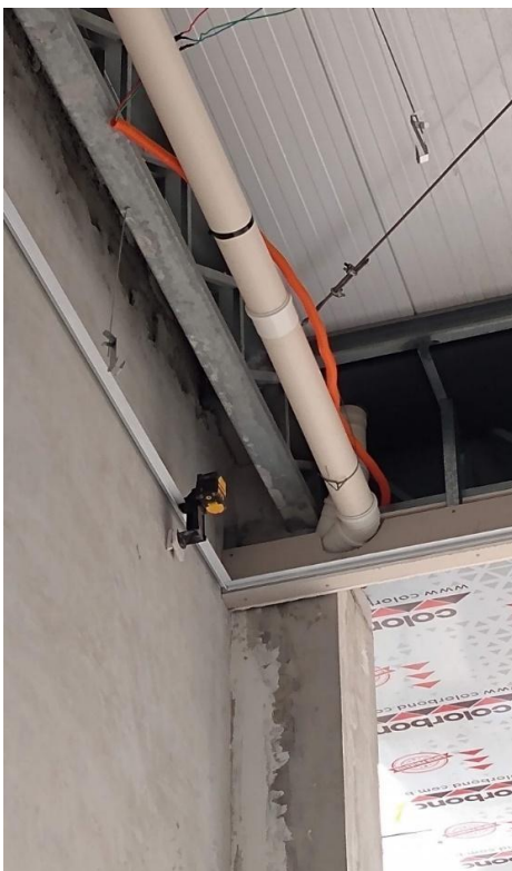
Figura 23 - Foto mostrando o nível do forro de drywall sendo tirado logo abaixo do ponto máximo da tubulação que passa no Lobby.
