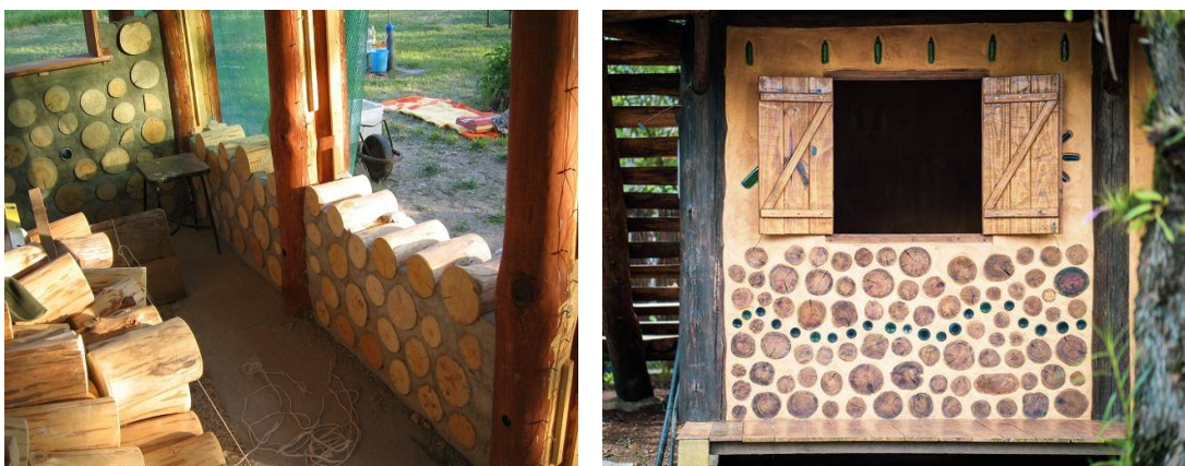
Figura 3 – Alvenaria de troncos de madeira construída pela Técnica Cordwood
