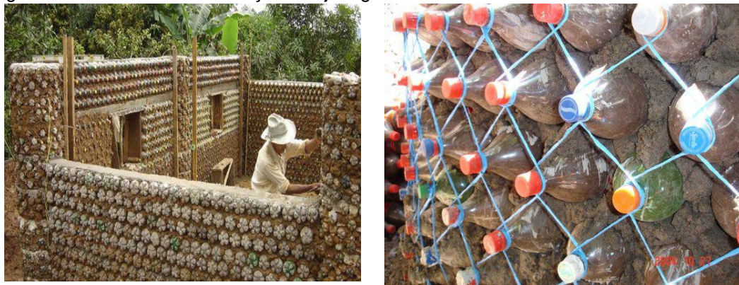
Figura 6 – Alvenaria com utilização de tijolo-garrafa
