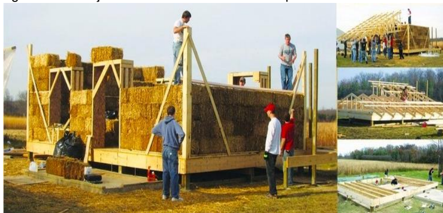
Figura 4 – Vedação e isolamento com fardos de palha
