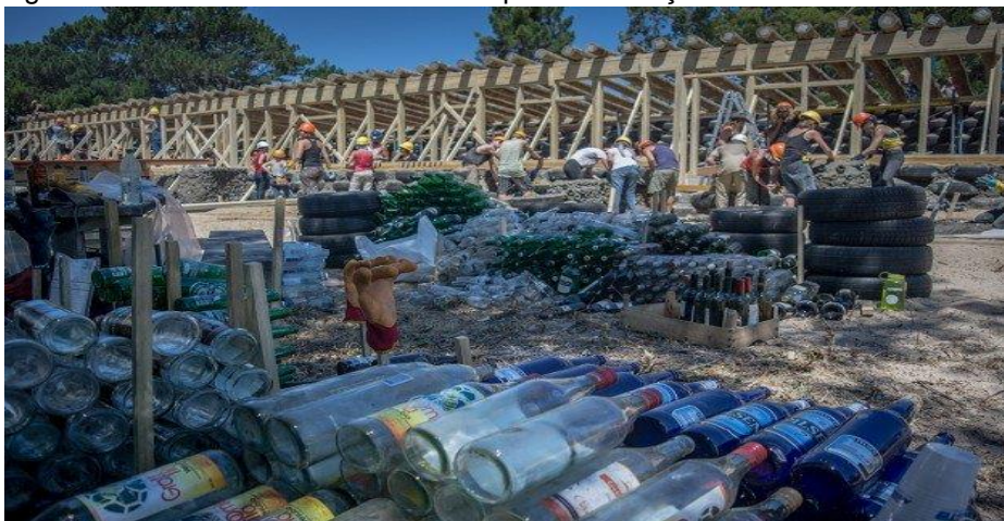
Figura 8 – Uso de materiais reciclados para construção da escola
