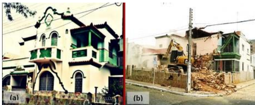
Figura 05 - Edifício Vila Doracy em 2013 (a) e sua demolição no mesmo ano (b)
