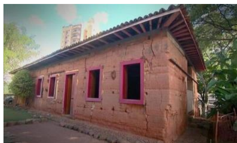
Figura 02 - Obra tradicional finalizada em sistema feito de barro.
