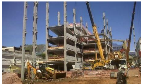
Figura 04 - Auxílio das máquinas na execução de um edifício.
