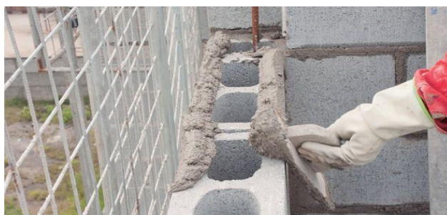
Figura 08: Argamassa sendo aplicada em blocos de concreto.
