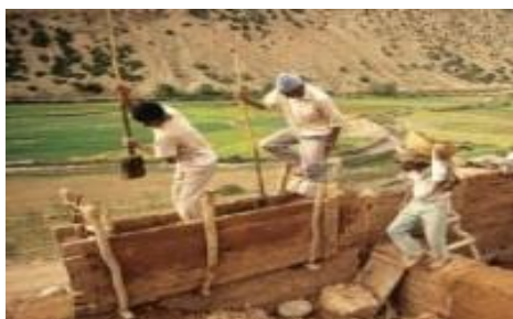
Figura 01 - Montagem das fôrmas em construção de barro.
