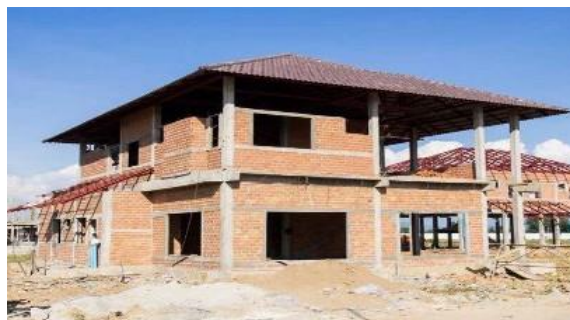
Figura 03 - Execução de uma obra em concreto armado.
