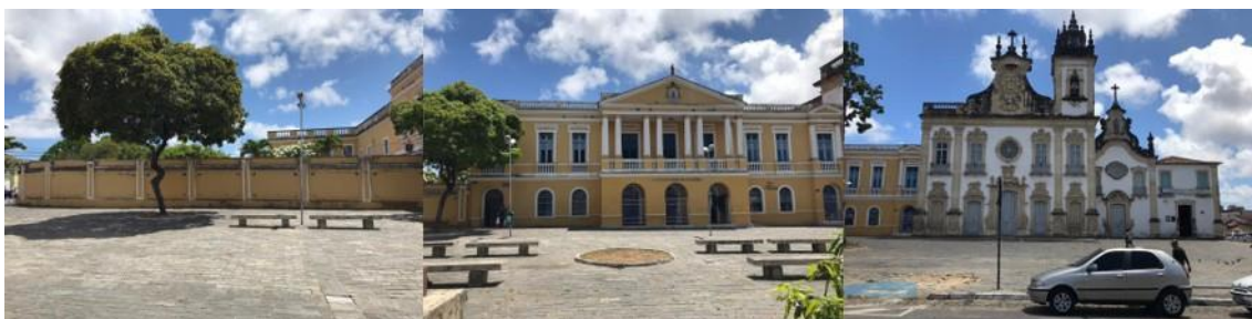
Figura 03 - Colagem de fotos (Trecho 01)
