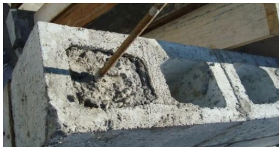
Figura 07: Graute sendo utilizado na fixação da armadura.
