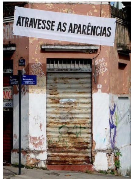
Figura 05 - Faixas de anti-sinalização: Série de faixas instaladas na região do bairro de Santa Tereza e arredores. Belo Horizonte – Minas Gerais
