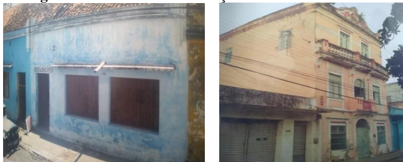
Figura 6- Rua da Areia. Edificações subutilizadas
