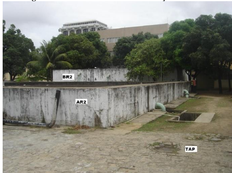
Figura 18 – Vista do centro de distribuição R2
