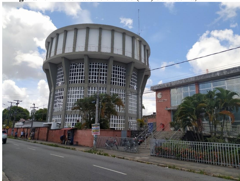
Figura 15 – Reservatório elevado (RE) do sistema, R1
