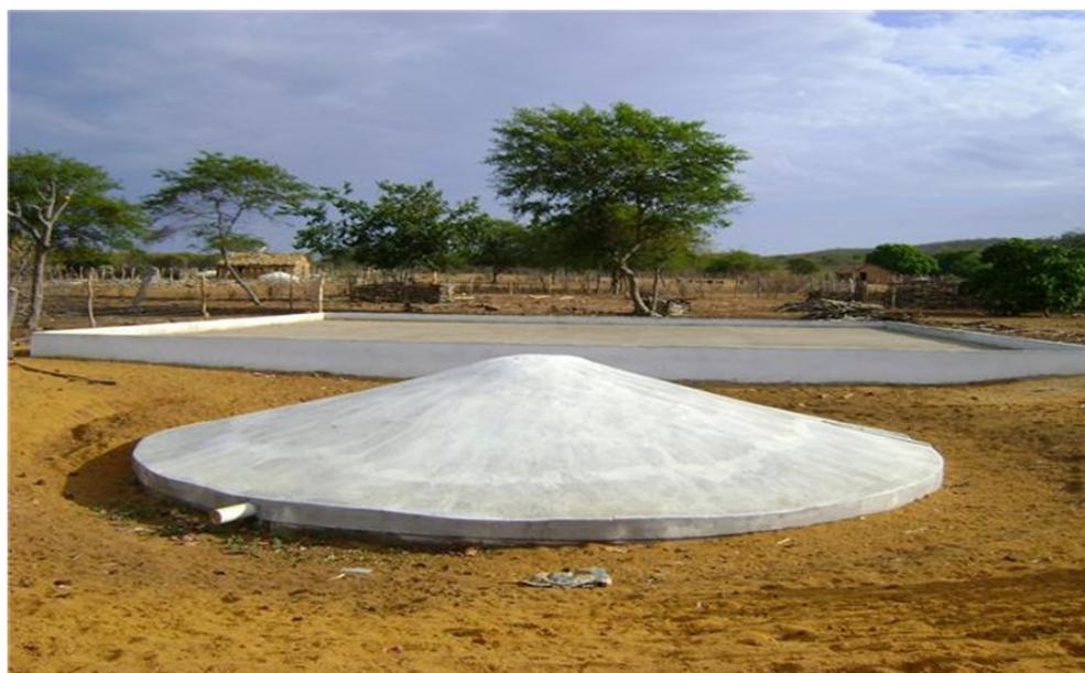
**Figura 3.** Cisterna tipo calçada. Zona Rural do Município de Livramento/PB. Fonte: Laboratório de Ecologia e Botânica/CDSA/UFCG. 2017.
