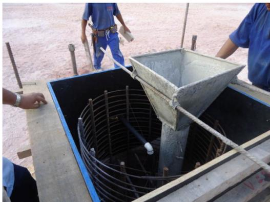
**Figura 9.** Concretagem do tubulão instrumentado.
