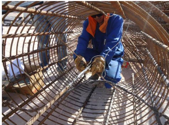
**Figura 8.** Barra instrumentada no eixo do tubulão.
