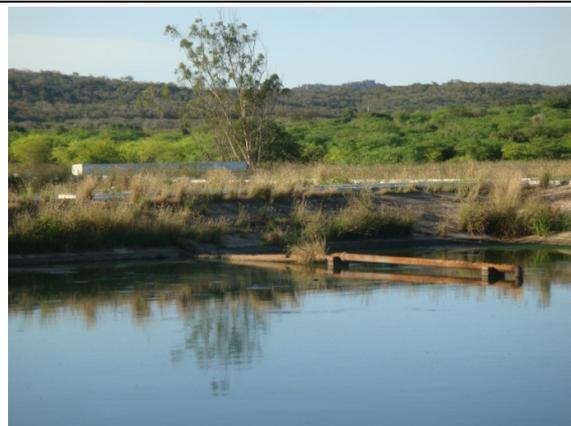
Entrada de esgotos na Lagoa de Estabilização Anaeróbia, observando-se a falta de limpeza da vegetação no talude interno da lagoa
