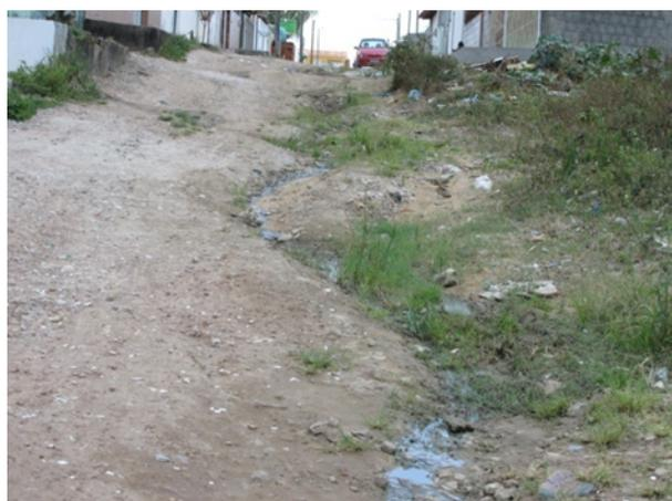
**Figura 15** – Características do Ponto 7 visitado: Falta de pavimentação e rede de coleta de esgoto sanitário.
